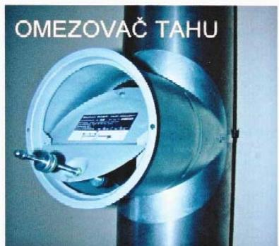
Při tahu komína nad 25 Pa při jmenovitém výkonu (doporučené maximum je 20 Pa) hrozí přetápění kotle a prohořívání paliva do násypky v útlumových režimech. Proto je nutné omezit tah komína omezovačem jeho instalace rovněž snižuje komínovou ztrátu při velkém tahu a omezuje přehřívání komínu (šetří komín). Nabízený omezovač lze jednoduše instalovat na rouru odtahu spalin a to ve svislé i vodorovné poloze.
